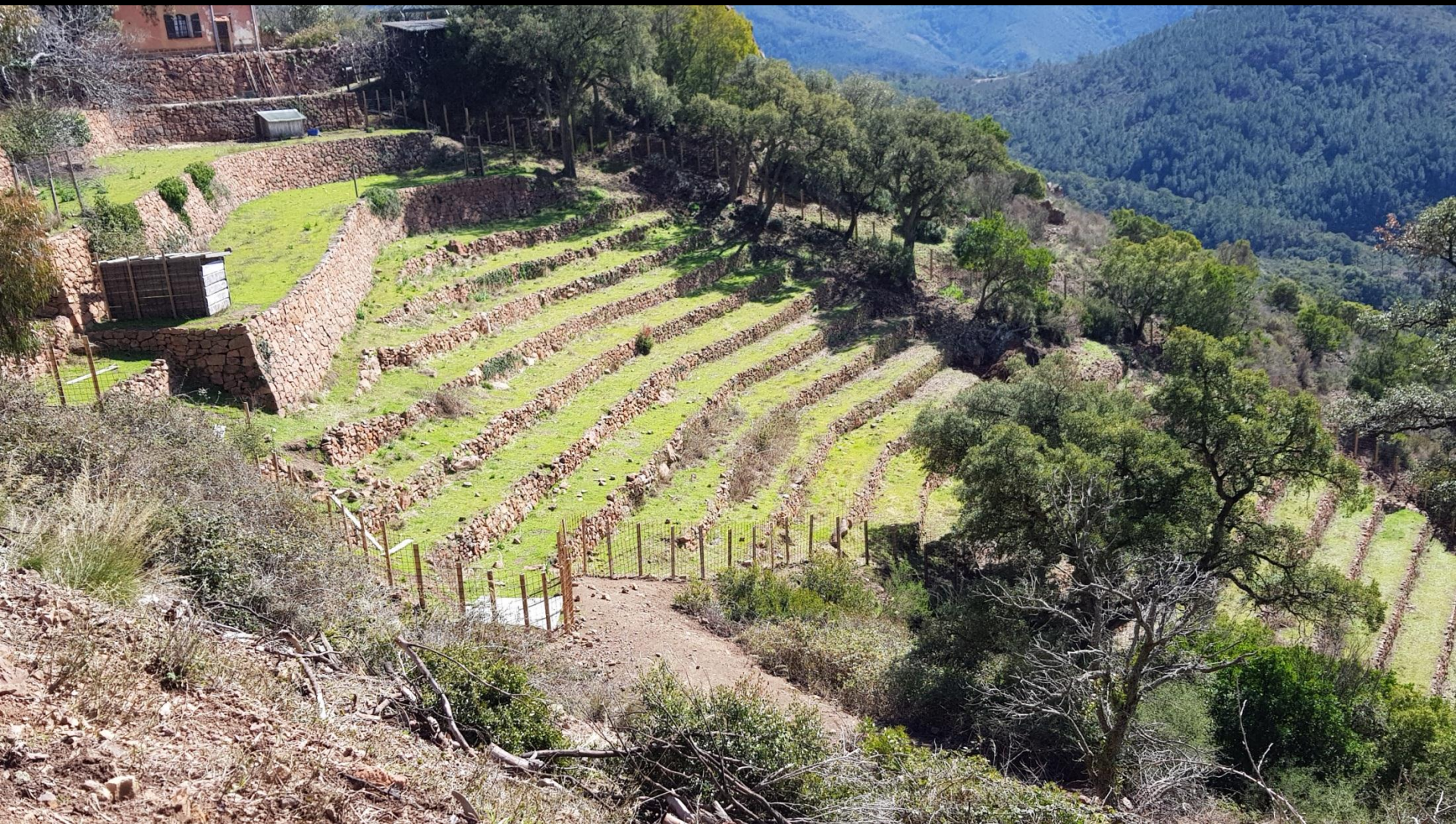
De belles restanques à la maison forestière du col des 3 Termes.
